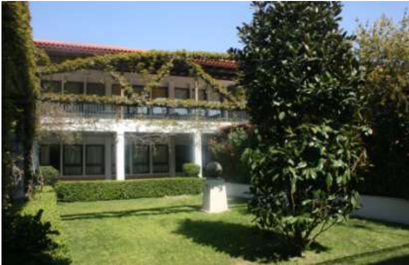
Το κτήριο της διοίκησης του ΤΕΙ
