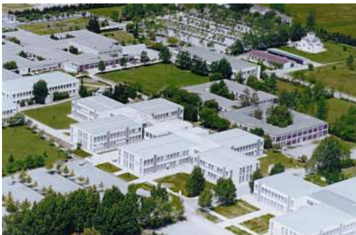
Μερική άποψη των κτιριακών εγκαταστάσεων του Α.Τ.Ε.Ι.Θ
