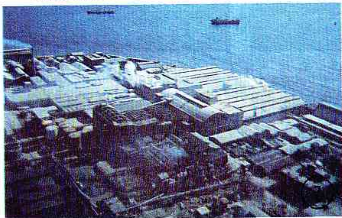
5. Εργοστάσιο λιπασμάτων στον Πειραιά
