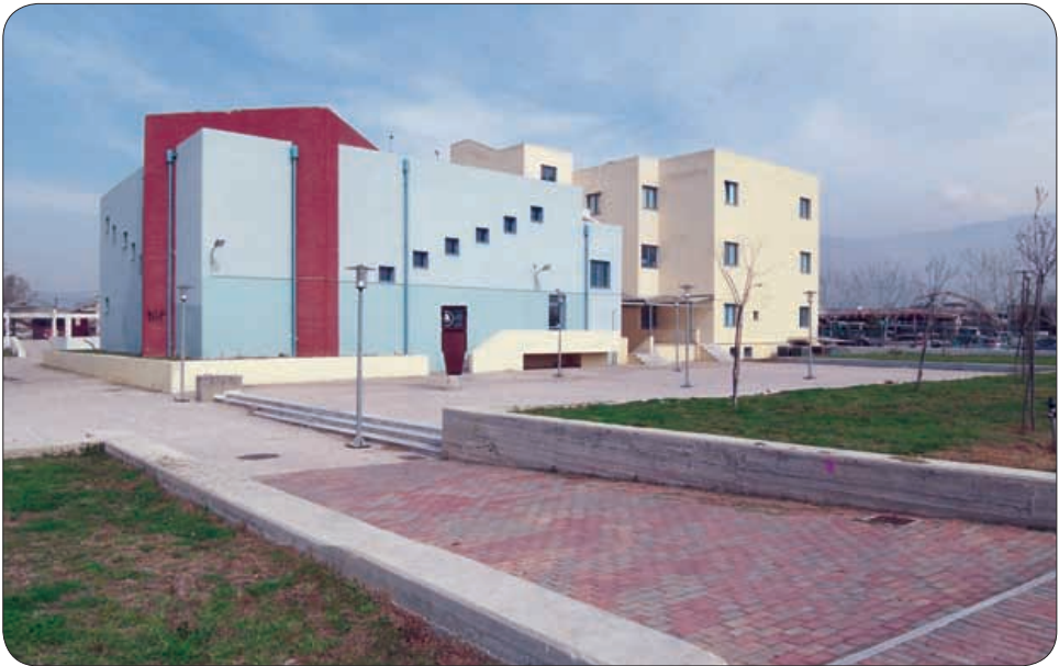
Κτήριο Τμήματος ΜΧΠΠΑ: Νοτιοδυτική όψη
