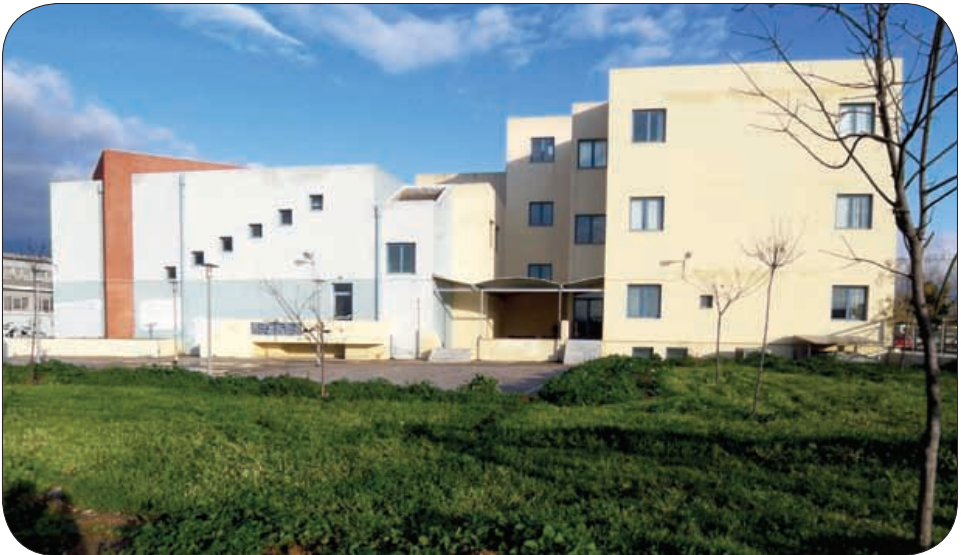
Κτήριο Τμήματος ΜΧΠΠΑ: Νότια όψη
